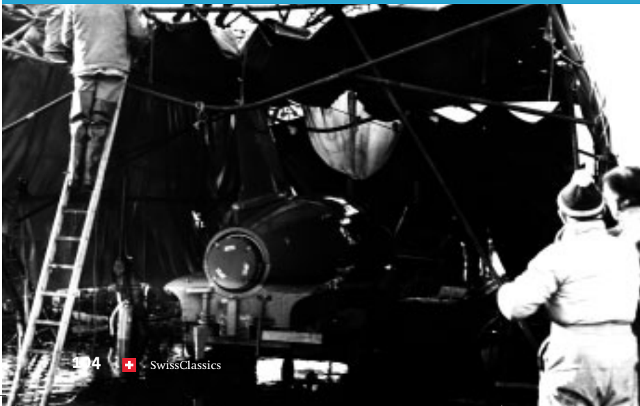
Unter diesem Zelt wurde die Gasturbine im Winter 1966 gewechselt. Bild: Paul Allonby
